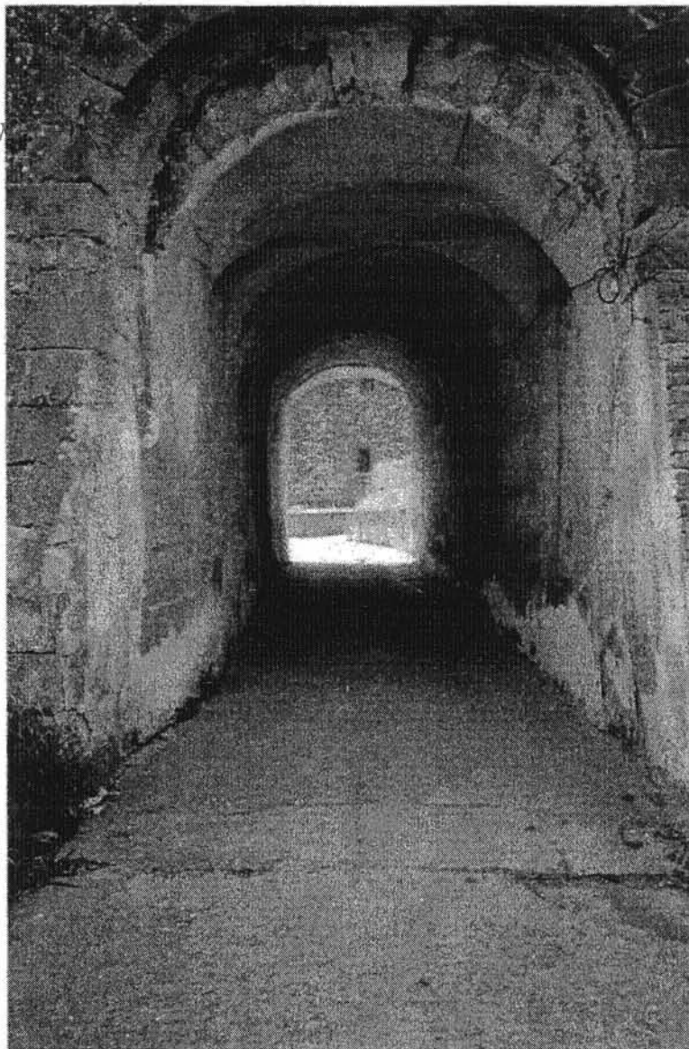
19. Wnętrze przejazdu bramnego od północy.
