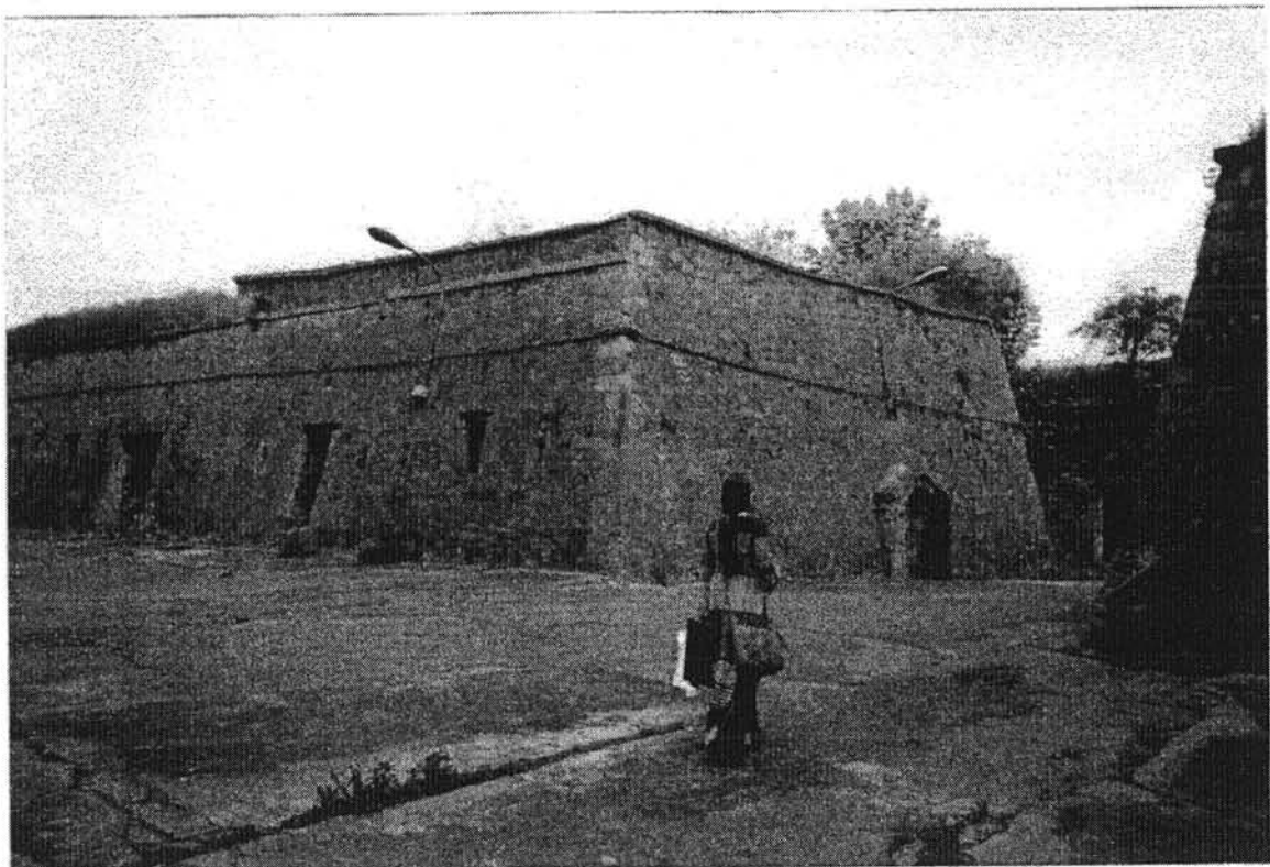
8. Widok od pd-wsch. na elewacje IV i V.
