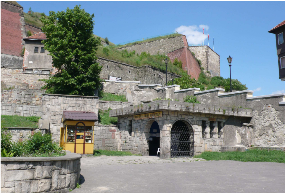
Wejście przy ul. Czeskiej.
