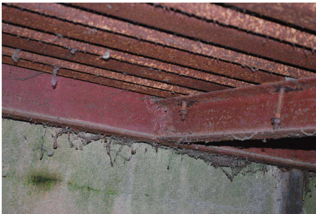
Rys.1.20. Płyta pomostu kładki dla pieszych. Widoczne ubytki korozyjne kształtowników pomostu, oraz odkręcone śruby
