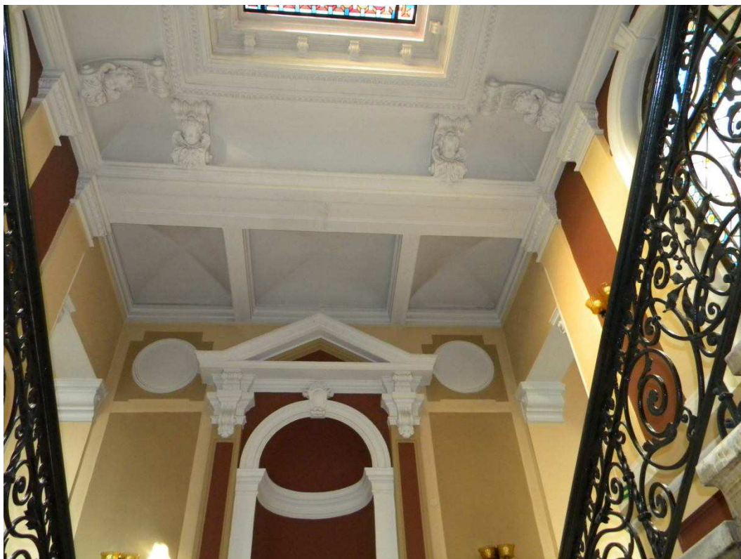
fot.1. Widok ogólny klatki schodowej głównej
