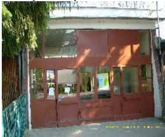
Elewacja od strony ul. Wolności
