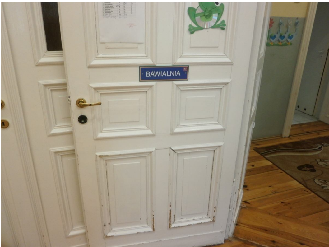
fot.6. Widok ogólny stolarki drzwiowej wewnętrznej.
