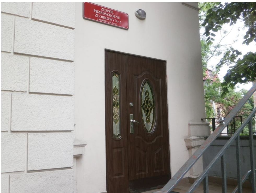
Fot. 2. Widok obecnie zamontowanej stolarki stalowej.
