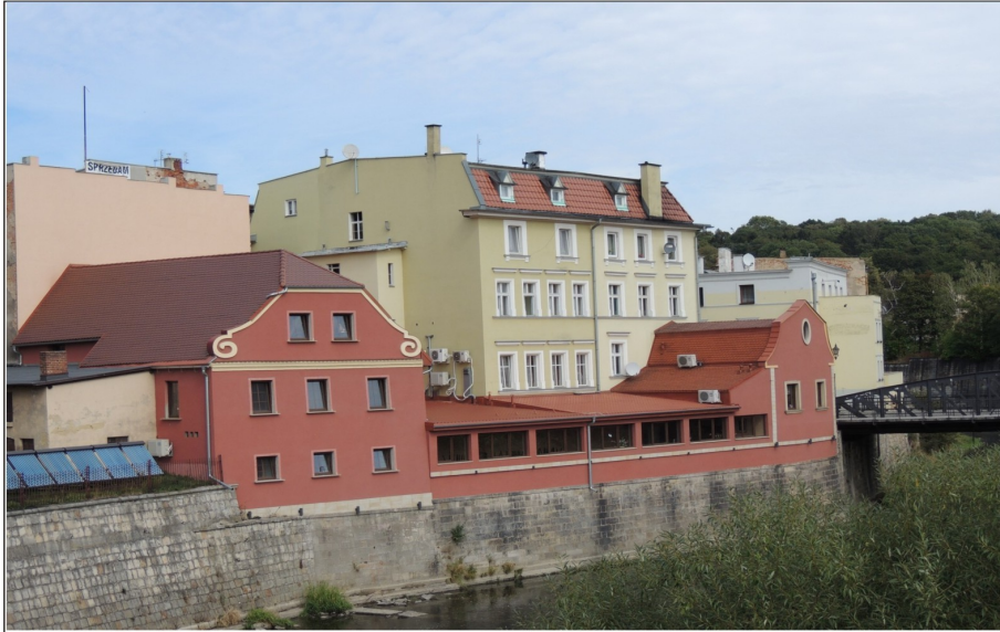
Renowacja po klęsce powodzi zabudowy w rejonie ulicy A.Grottgera
