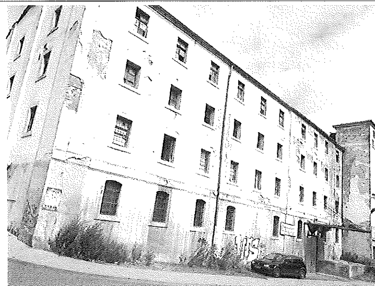
F15. Elewacja tylna. Widok ogólny. Liczne ubytki tynków.
