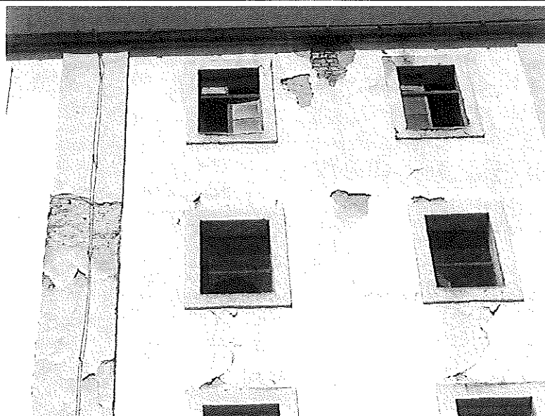
F27. Elewacja tylna. Rysy na murze oraz liczne ubytki tynków.
