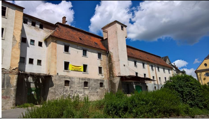
Fot.9 Ul. Łukasińskiego 30 Elewacja wschodnia
