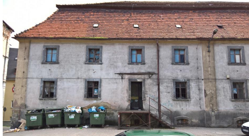
Fot.2 Ul. Łukasińskiego 30 Elewacja zachodnia
