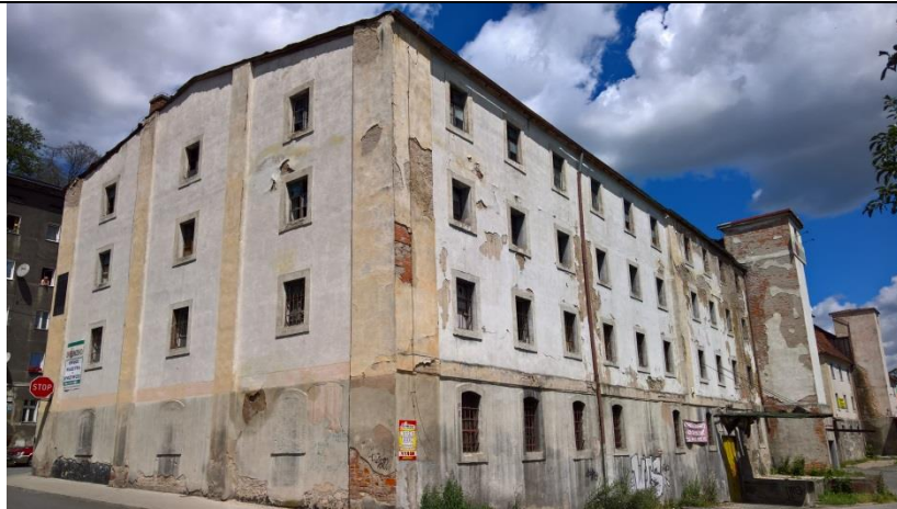
Fot.10 Ul. Łukasińskiego 28 Elewacja wschodnia
