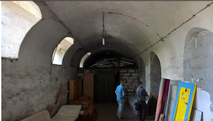
Fot.13 Łukasińskiego 28 Piwnica
