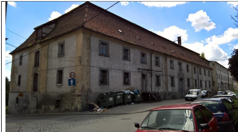
Fot.1 Ul. Łukasińskiego 30 Elewacja zachodnia
