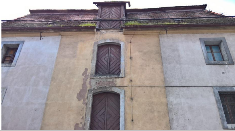
Fot. 12 Ul. Łukasińskiego 30 Elewacja północna
