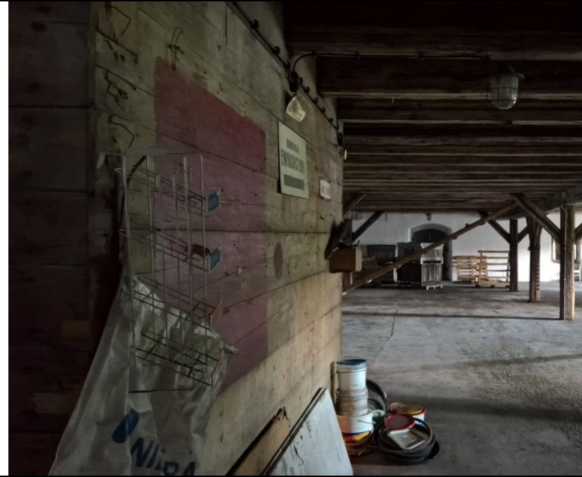
Fot. 24 ul. Łukasieńskiego 30 Obudowa drewnianej klatki schodowej
