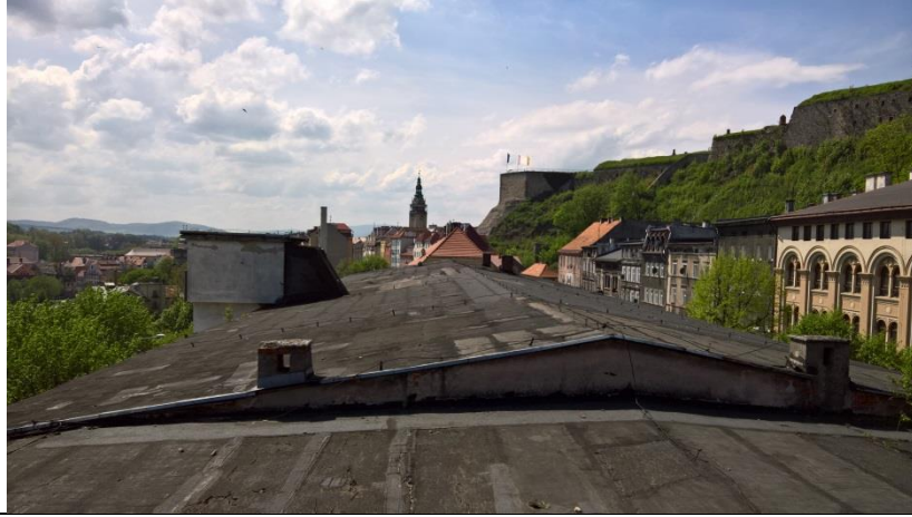
Fot. 32 ul. Łukasińskiego 28 Pokrycie dachu
