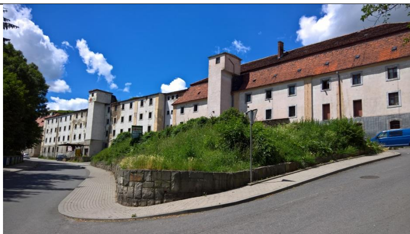
Fot.8 Widok od strony ulicy Kolejowej Wschodnie elewacje budynków
