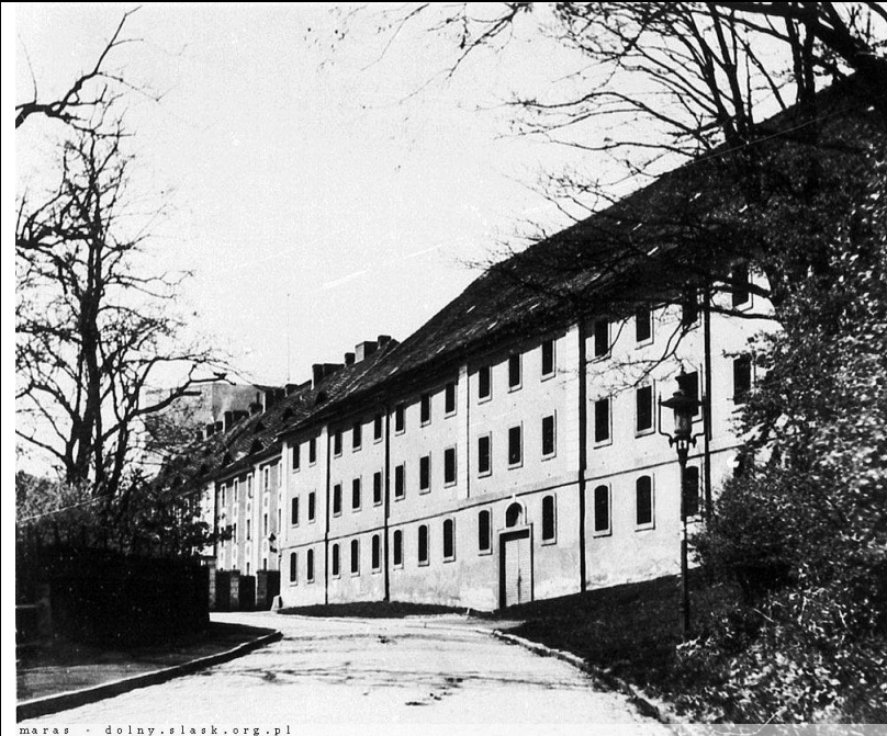
Fot. 35 ul. Łukaszyńskiego 28 i 30 Fotografia archiwalna /Elewacje wschodnie/
