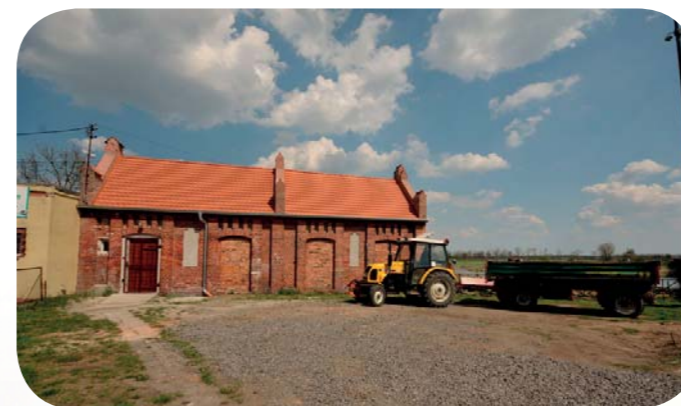
Budynek gospodarczy obsługujący przystań po remoncie, fot. Paweł Flunt
